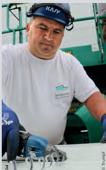
3 Für Längsschnitte in Dünnblech setzt Mitarbeiter Radomir Krivokuca am liebsten die Akku-Schlitzscheren TruTool C160 ein. Mit ihr schafft er eine Arbeitsgeschwindigkeit von bis zu neun Metern pro Minute.
