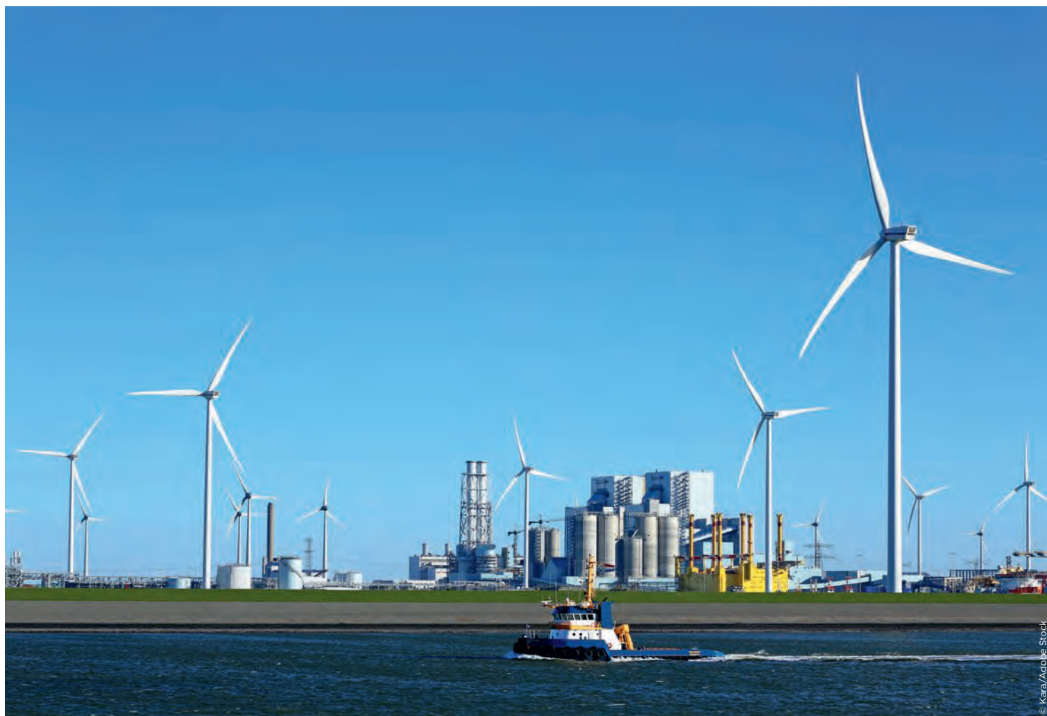
Im niederländischen Energiepark Eemshaven – hier ein kleiner Ausschnitt – treffen Vergangenheit und Zukunft aufeinander; Wind und Sonne, Steinkohle und Erdgas. Zeitweise wurde auch ein AKW diskutiert. Weitere Anlagen sind geplant, unter anderem ein GuD-Kraftwerk mit über 60 Prozent Wirkungsgrad.
