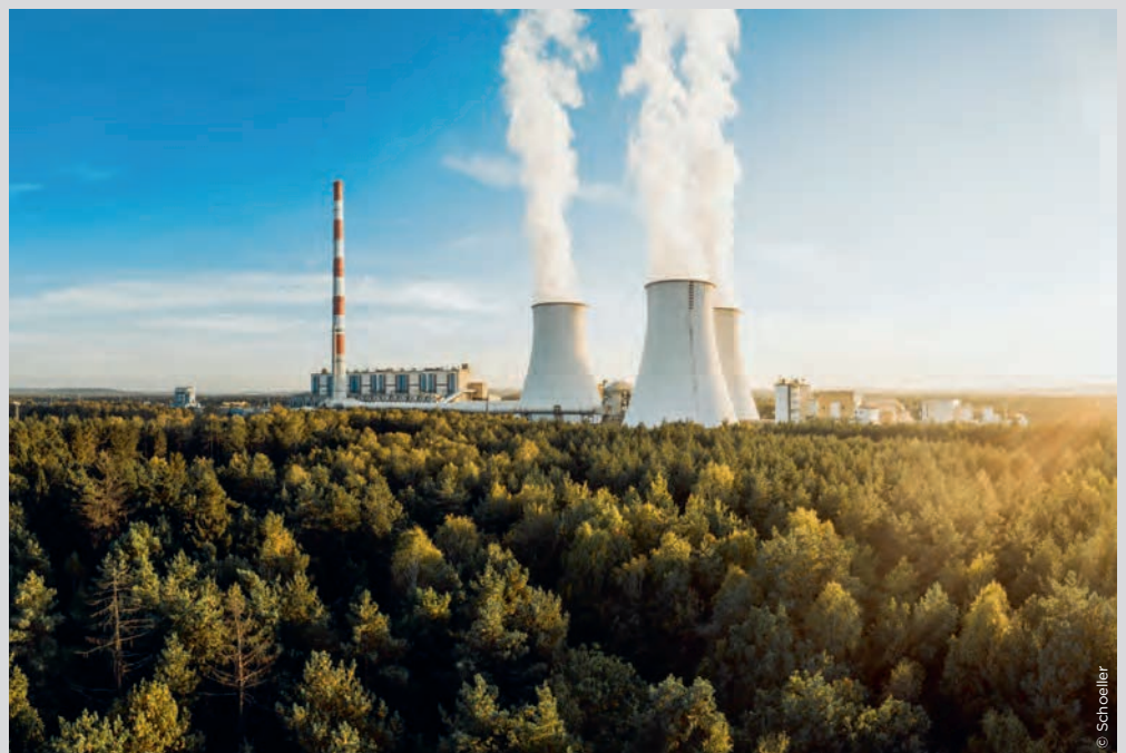
Der Energiehunger wächst weltweit, Schoeller profitiert deshalb als Lieferant von Edelstahlrohren für Kraftwerke.
