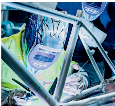
44_Gefahr Rauchgase Eine gute Arbeitsumgebung fängt beim Schutzgas an
