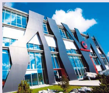
Logistikzentrum der Mammut Sports Group
